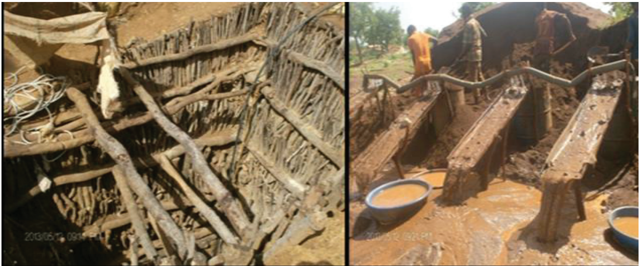
Figure 7 : Calage des trous par des étais
